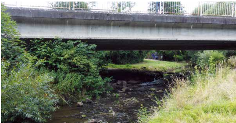
Obr. 48. Pohled na profil mostu, stav k 21. červenci 2023 (foto: L. Kašpárek)
