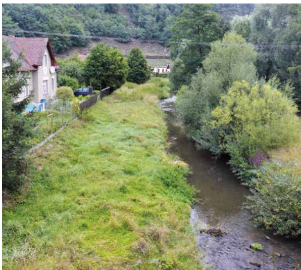
Obr. 49. Pohled z mostu u čp. 79 po proudu, stav v srpnu 2023 (foto: L. Kašpárek)
