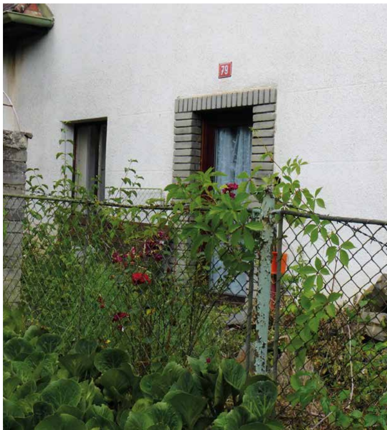
Obr. 10. Okna domu čp. 79 v Městečku, v úrovni horních rámců byla značka hladiny povodně z roku 1872, cca 4,5 m nad úrovní dna potoka (foto a archiv L. Kašpárka)
