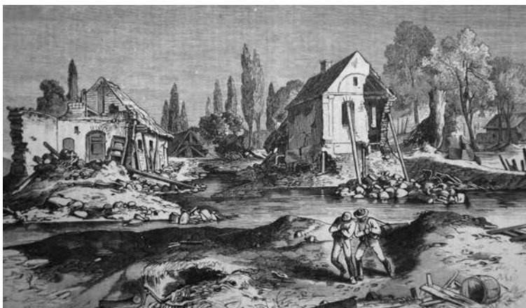
Obr. 33c. Dům čp. 123 poškozený roku 1872, stav kolem roku 1920
