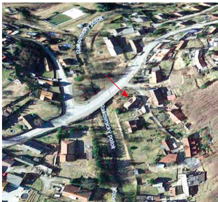
Obr. 47. Pohled na část Městečka, označen dům čp. 79 (použit Google Earth)
