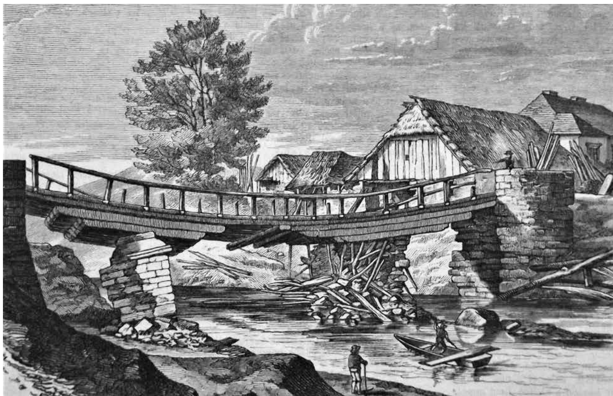
Obr. 43. Poškozený most v Rakovníce (Skrejšovský, 1873)
